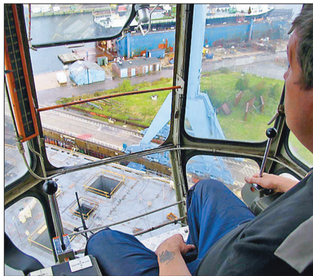
Med van hand lyfts de tunga sektionerna på plats med hjälp av en 50 meter hög kran.
