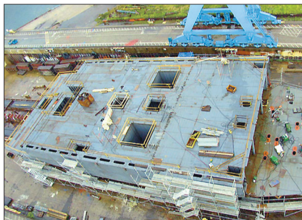
Mittendelen av fartyget är snart klar, sedan monteras fören och aktern. I februari ska fartygsskrovet seglas till Norge där det färdigställs som dykarfartyg.
